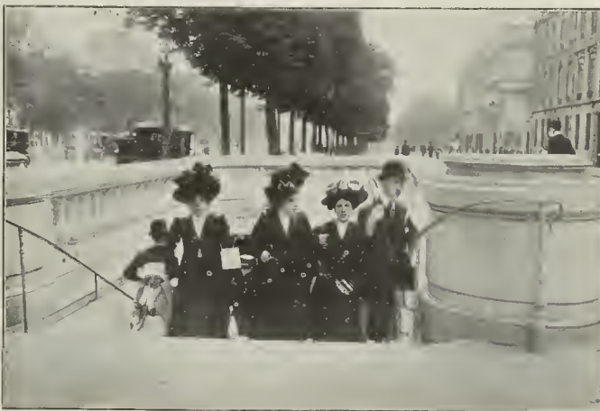
París.—Galería subterránea para el paso de peatones en el ángulo de la Avenida de los Campos Elíseos y de la calle de Marbeuf. (De fotografía de M. Rol.)
